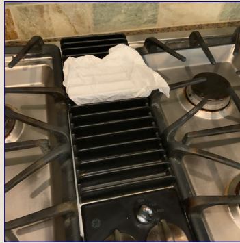
Exhaust fan operational.
